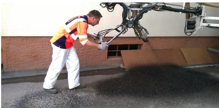
La société EUROVIA a procédé à une démonstration du Blow Patcher, nouvelle technologie innovante de mise en œuvre d'enrobés projetés, solution alternative économique pour les réparations ponctuelles des chaussées qui relèvent de la compétence communale.
